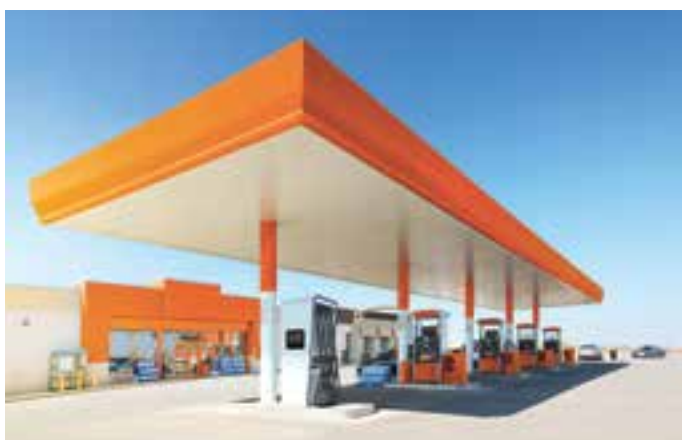
Die Tankstelle der Zukunft: E-Ladesäulen in einer Reihe mit klassischen Zapfsäulen.
