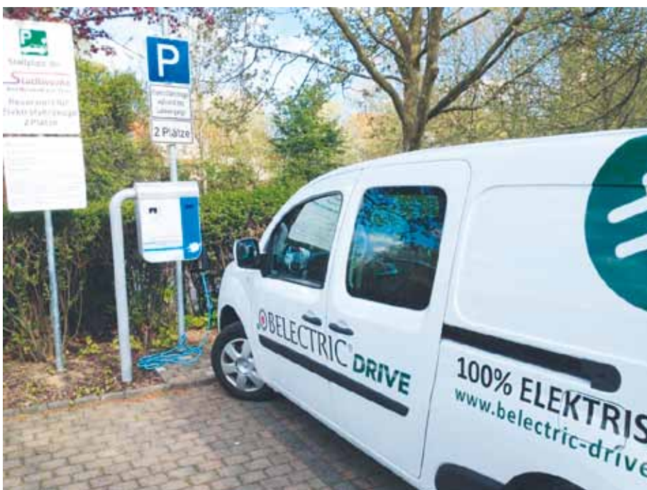
Frei stehende Ladestöcke zur Beladung eines Elektromobils. Quelle: www.belectric-drive.com
